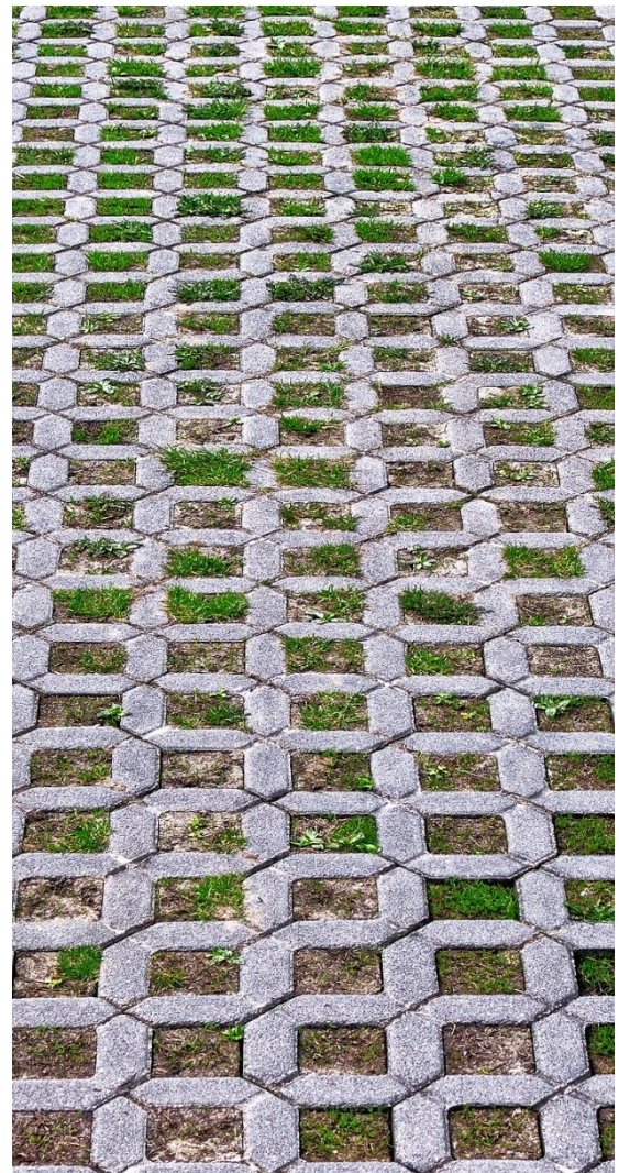
Abbildung 24: Rasengitter anstelle von undurchlässigem Asphalt
